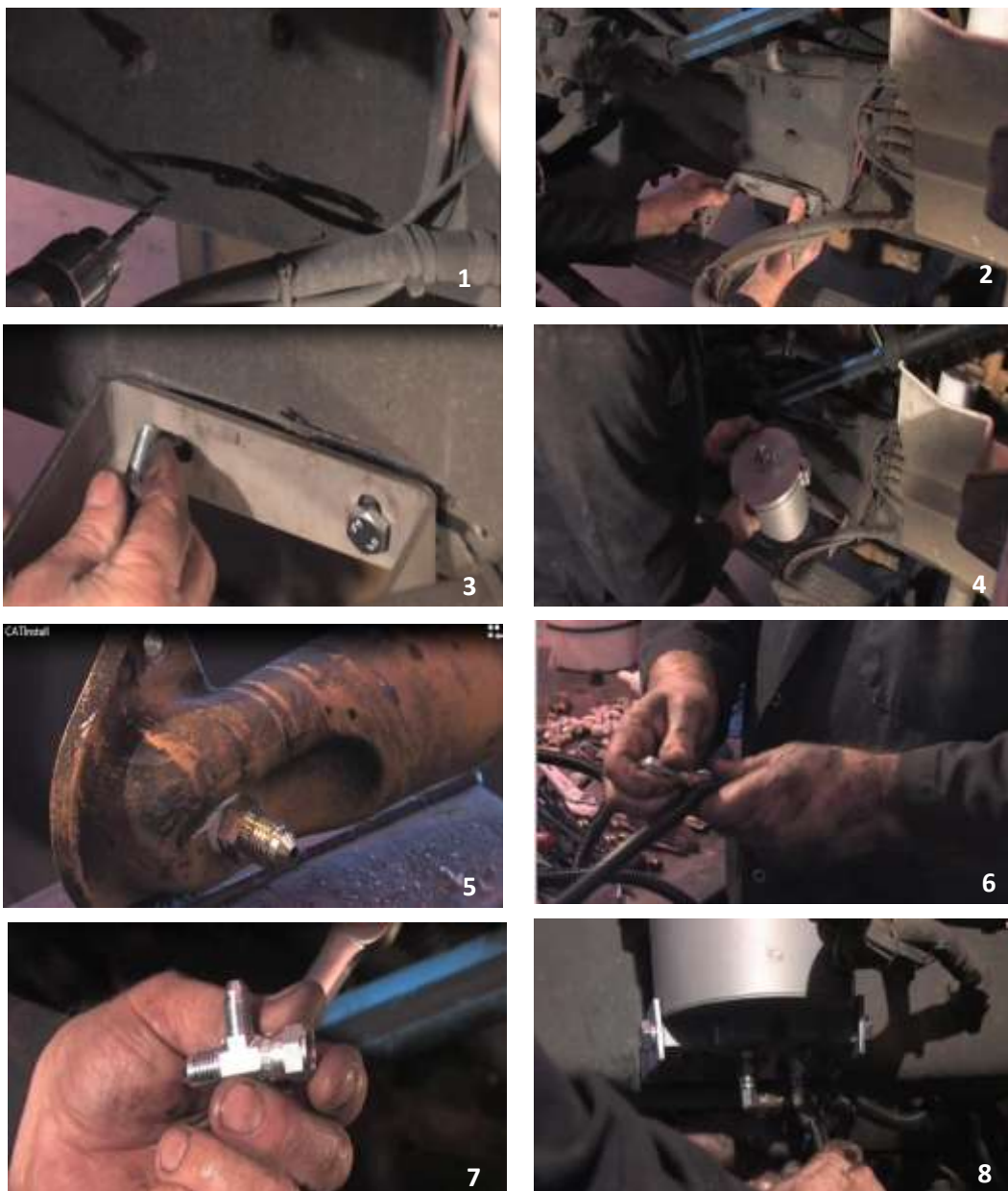
Figura 5. Instalación del sistema de nanofiltración.
